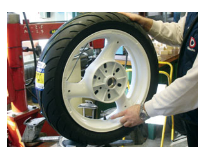
Fig. 5 : Positionnez le pneu non gonflé verticalement.
